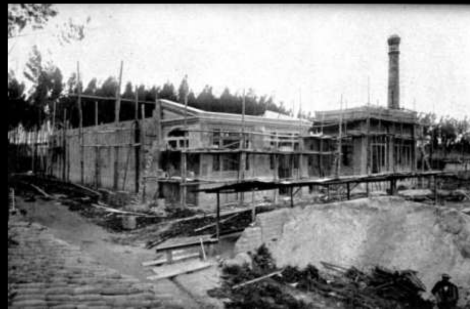
Matadero público en construcción. Fuente Registros Municipales.
